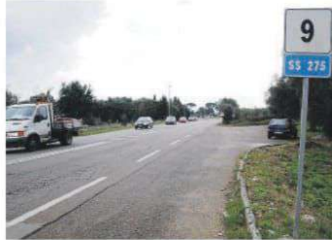
STATALE 275 A breve inizieranno i lavori del primo lotto
